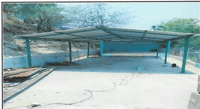
Foto 3: colocación de lamina.
