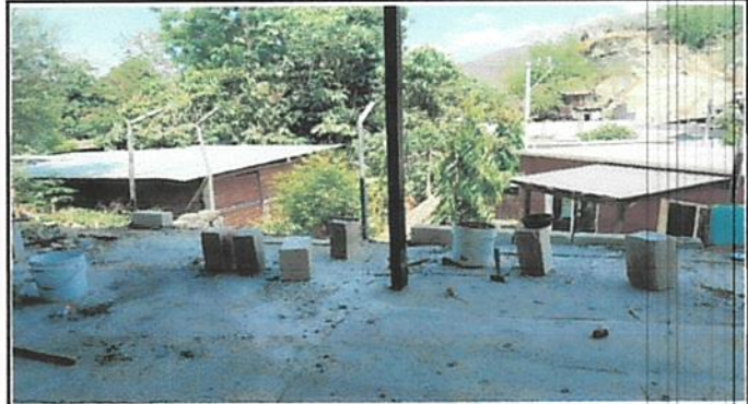
Foto 2: muro a un costado, lado derecho.
