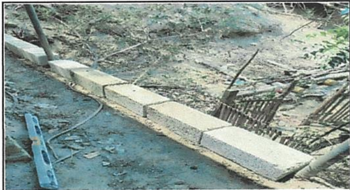
Foto 1: proceso de la sustitución del muro, lado atrás.
